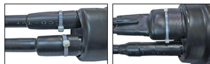
**Примечание:** При усадке на патрубок оголовника муфты ТУТ, на внутренней поверхности которой у одного из торцов имеется участок без клея-расплава, этот участок следует ориентировать в сторону оголовника. При усадке такого отрезка ТУТ за счет наличия у нее участка без клея-расплава предотвращается сползание ТУТ, т.е. не требуется закрепление ТУТ на патрубке в ходе ее усадки.
